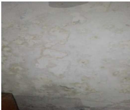
Figura 24. Pared interior de prueba
