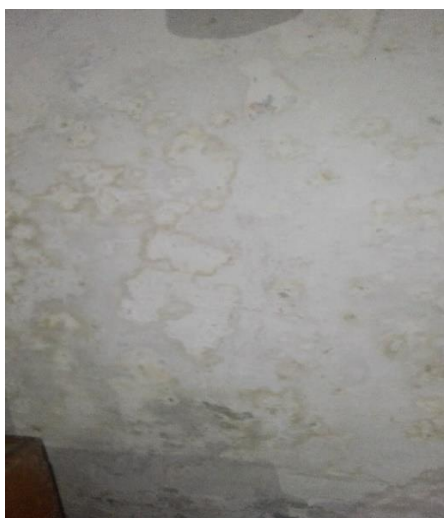
Figura 37. Mampostería en su primera visita
