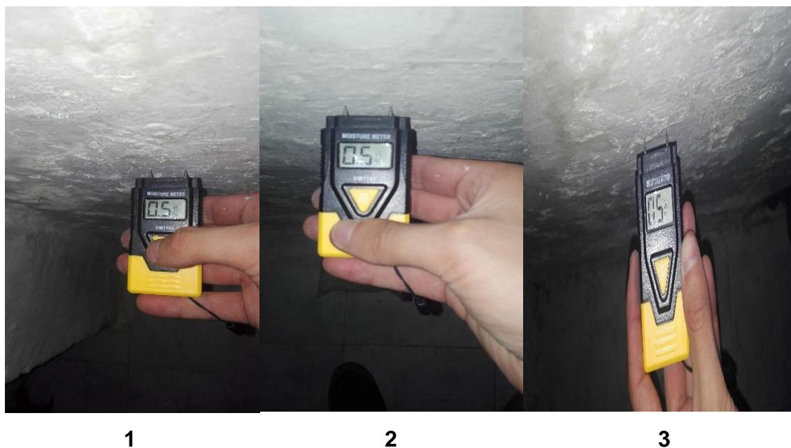
Figura 33. Medición de humedad en pared después de 4 semanas
