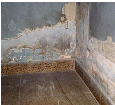
Figura 10. Humedad por Accidentes Dados Tomado de: Soluciones especiales, (2014)
