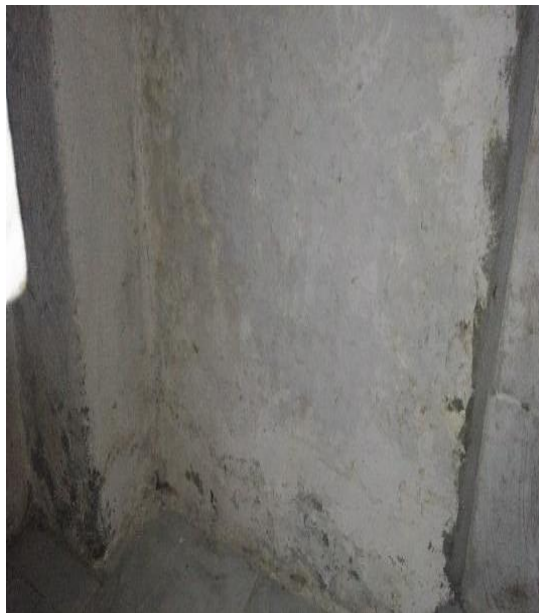
Figura 39. Mampostería después de dos semanas
