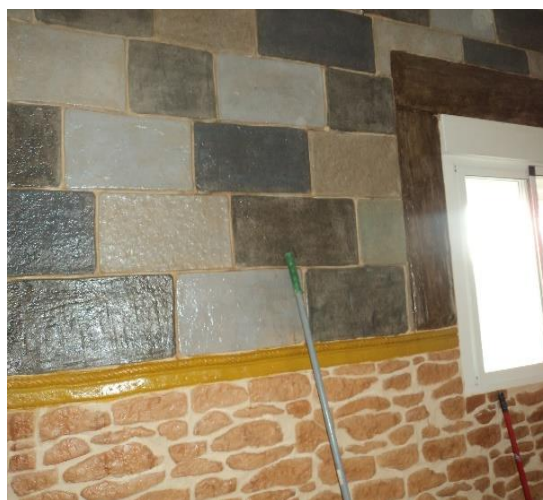
Figura 19. Mampostería De Decoración Tomado de: Relieve en paredes, (2012)
